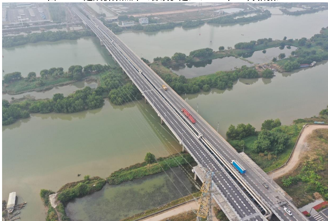
图 2.1-3 建成桥梁照片（含改扩建）（2023 年 12 月拍摄）
