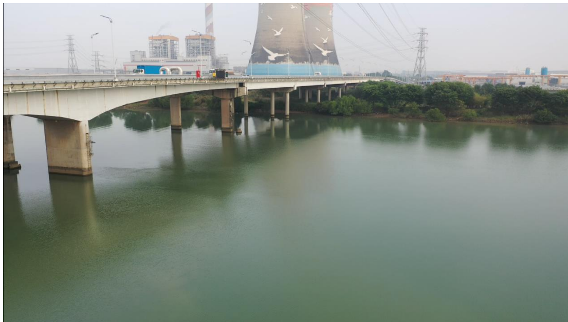
图 2.1-2 建成桥梁照片（含改扩建）（2023 年 12 月拍摄）
